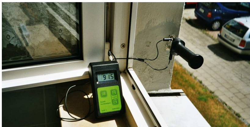
Messung der Wandfeuchte
